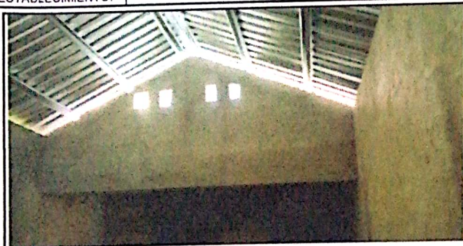
Foto 1: Luego de haber realizado los diferentes procesos de remodelación de la cocina
